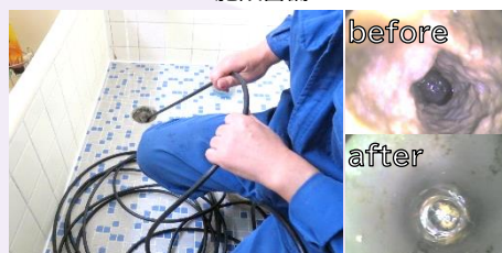
排水管高圧洗浄
