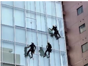
高所ロープ作業(硝子清掃)
