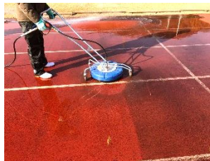
屋外高圧洗浄
