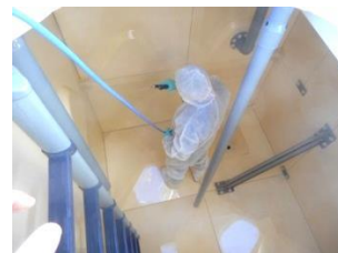
貯水槽清掃消毒作業
