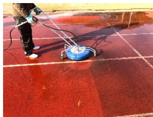
屋外高圧洗浄
