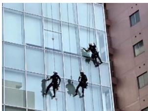
高所ロープ作業(硝子清掃)
