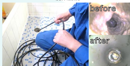
排水管高圧洗浄
