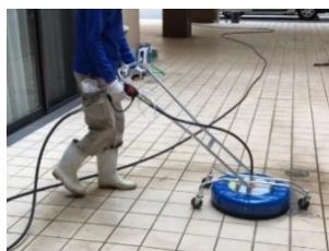
屋外高圧洗浄
