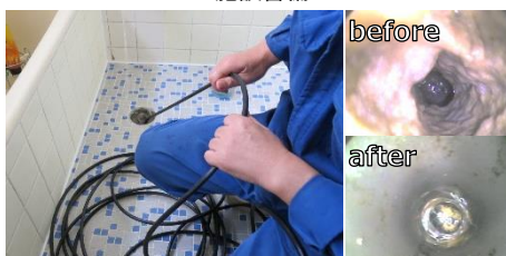
排水管高圧洗浄
