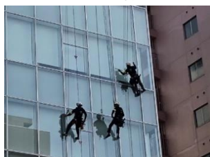
高所ロープ作業(硝子清掃)
