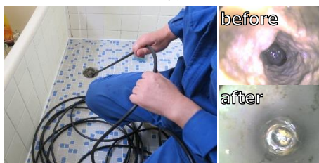
排水管高圧洗浄
