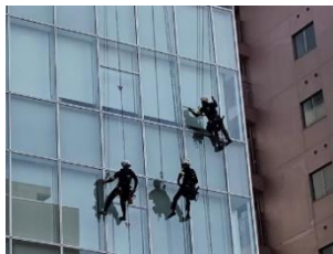
高所ロープ作業(硝子清掃)
