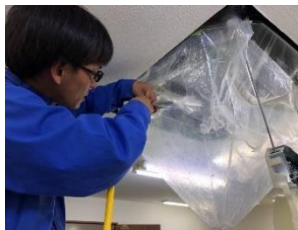
エアコン分解洗浄
